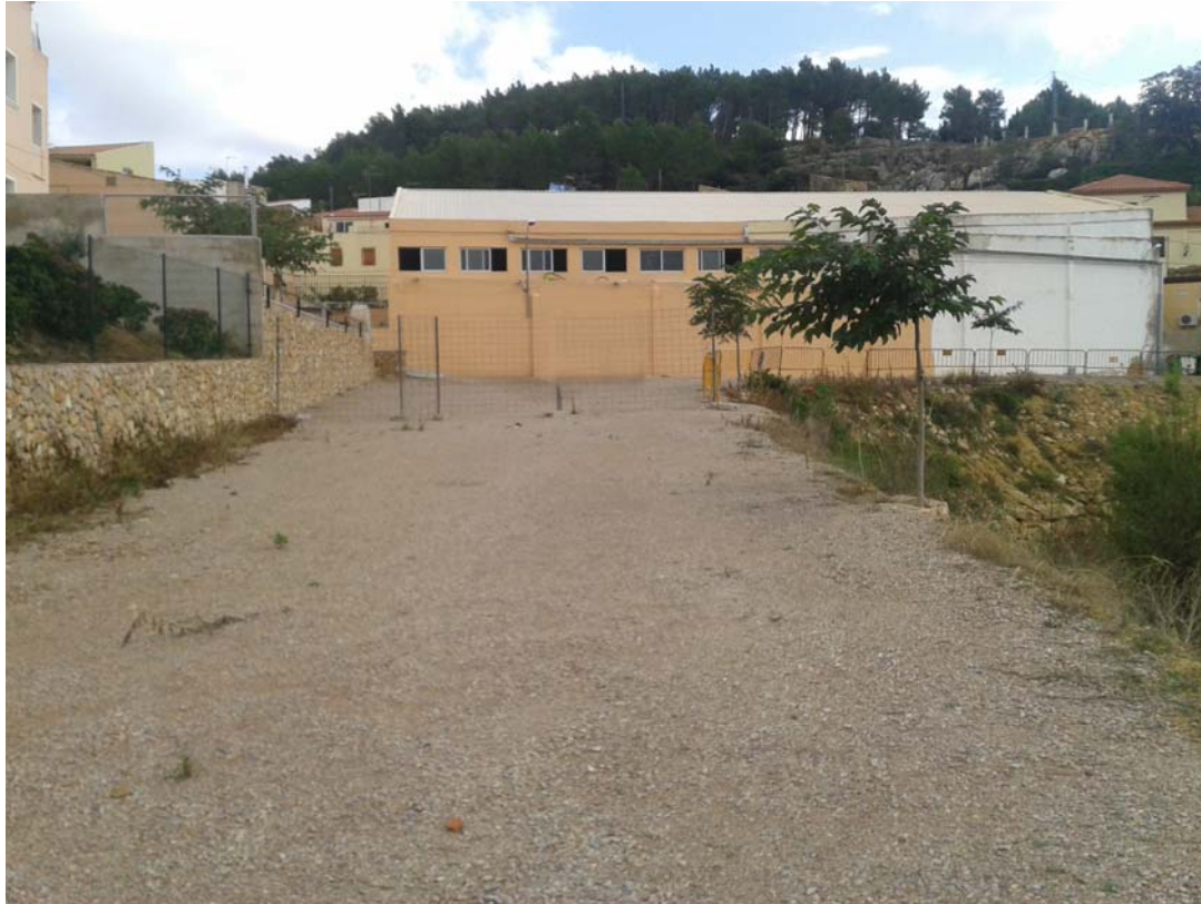
ZONA DE ACTUACION, VISTA FRONTAL DEL POLIDEPORTIVO . En parte derecha inferior se aprecia el talud de la calle protegido actualmente con una barandilla de obra.
