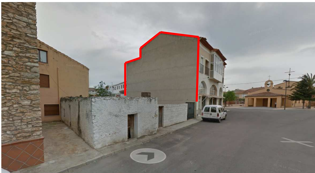
F3 -Els Ibarsos – Vista de la parcela que se pretende reclasificar a R2. Al fondo medianera que se pretende cubrir.
